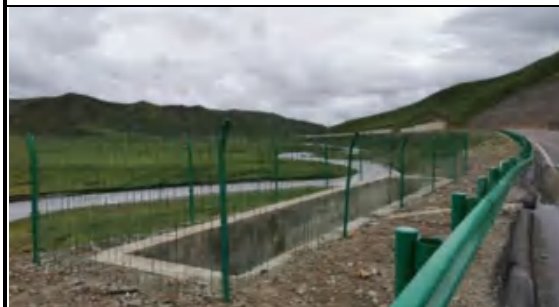
K52+270 事故应急池
