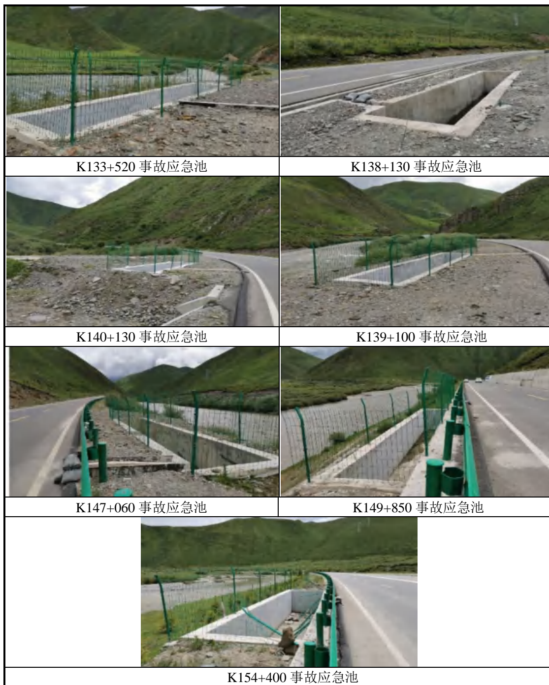
图 6.3-1 桥梁径流收集系统照片
