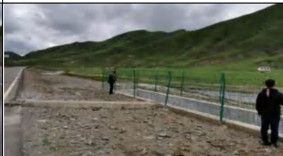
K113+770 事故应急池
