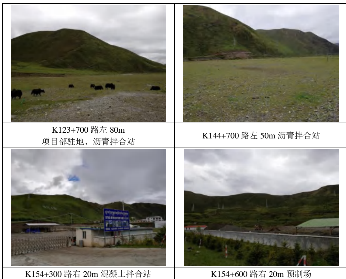
图 4.3-3 公路沿线施工场地照片
