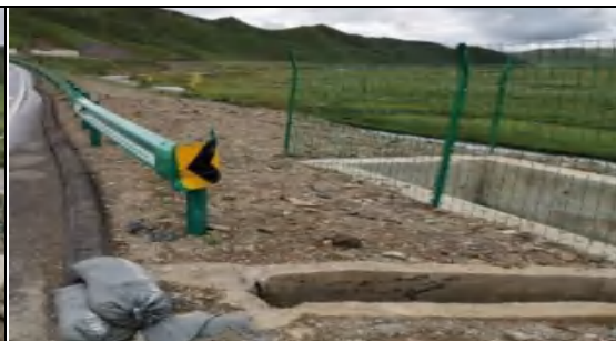
K51+470 事故应急池
