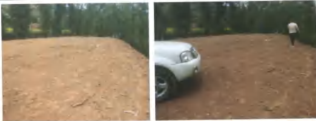
K27+200 清运恢复现场
