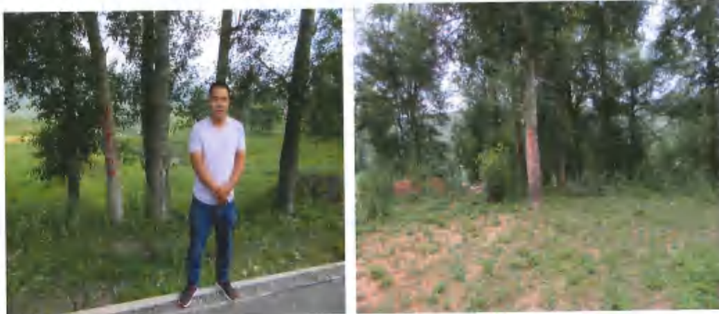
已整改恢复后绿化的路基两侧
