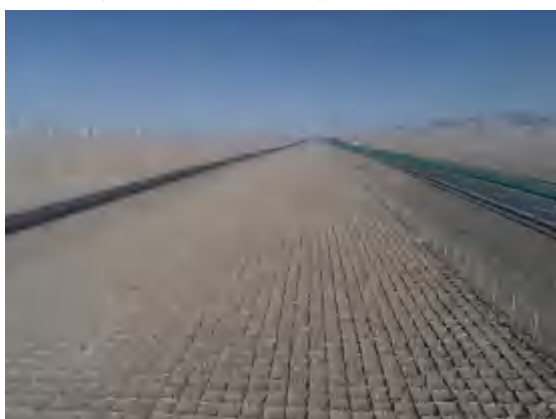
路基工程区片石方格网沙障
