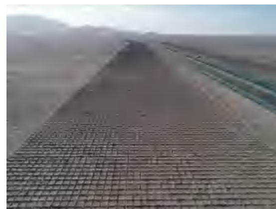
路基工程区片石方格网沙障
