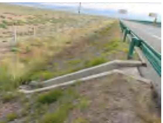
路基工程区边坡急流槽
