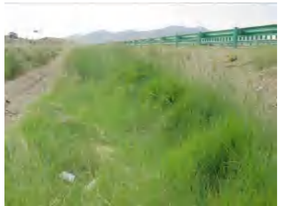
路基工程区边坡植被恢复
