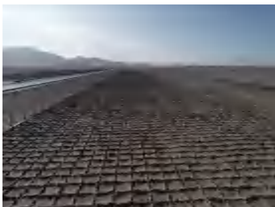
路基工程区片石方格网沙障
