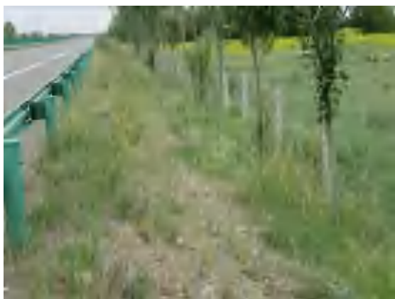
路基工程区边坡植被恢复
