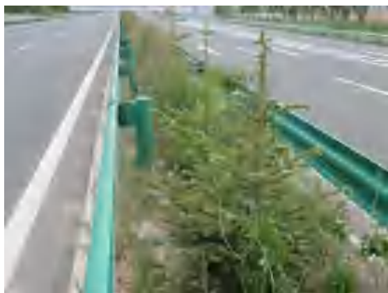
路基中央分隔带植被恢复
