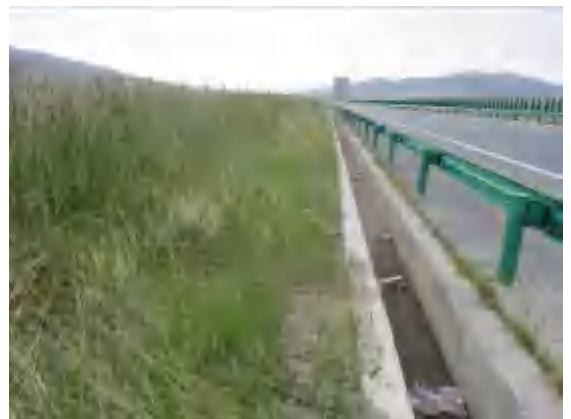
路基工程区边坡植被恢复
