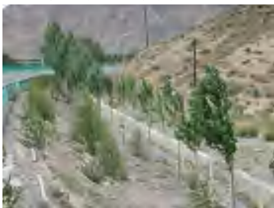
路基工程区边坡植被恢复
