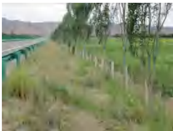
路基工程区边坡植被恢复
