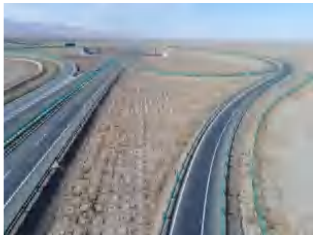
伊克高里收费站建设后遥感影像图
