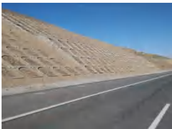
路基工程区骨架护坡
