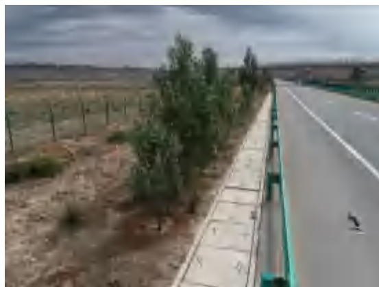
路基工程区排水沟
