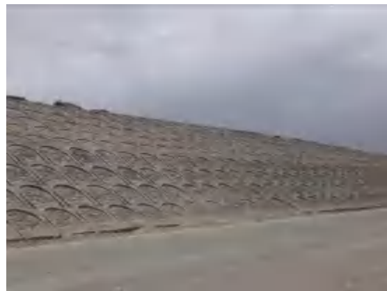
路基工程区骨架护坡
