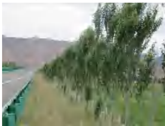
路基工程区边坡植被恢复
