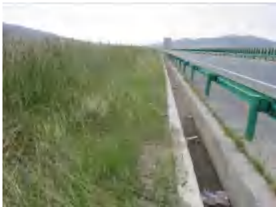
路基工程区排水沟
