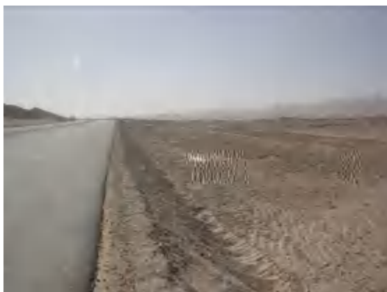
路基边坡土地整治及覆土
