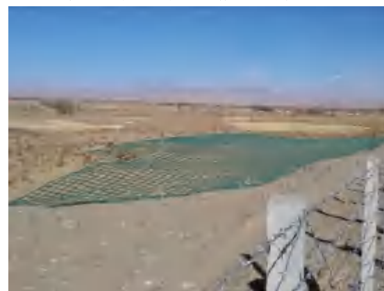
路基工程区尼龙网格沙障
