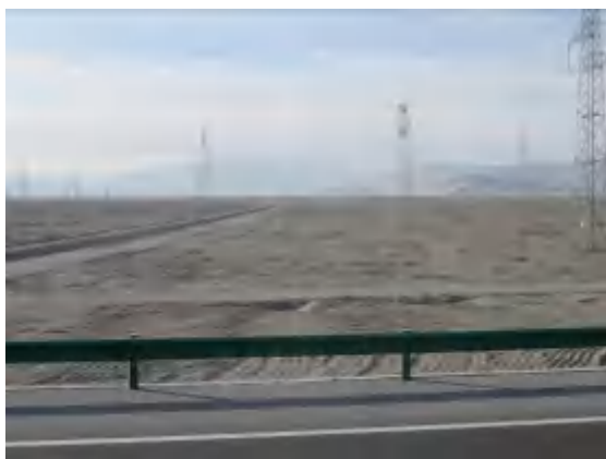
K2594+500 施工生产生活区恢复状
