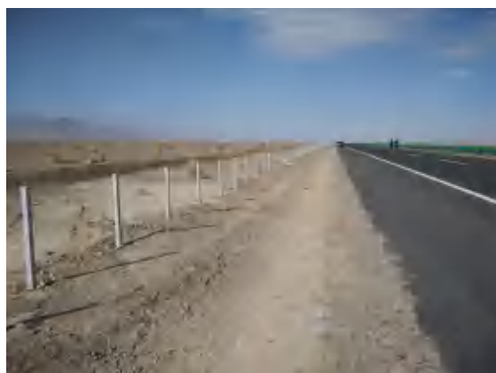
路基边坡土地整治及覆土
