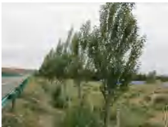
路基工程区边坡植被恢复
