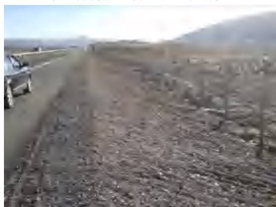
路基边坡土地整治
