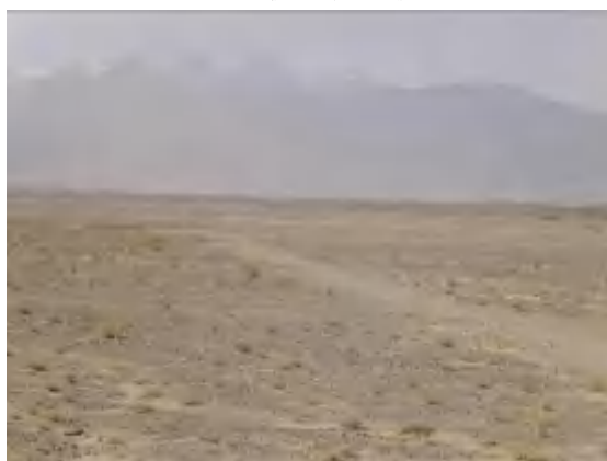
K2504+000 施工便道恢复状
