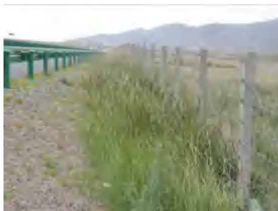
路基工程区边坡植被恢复
