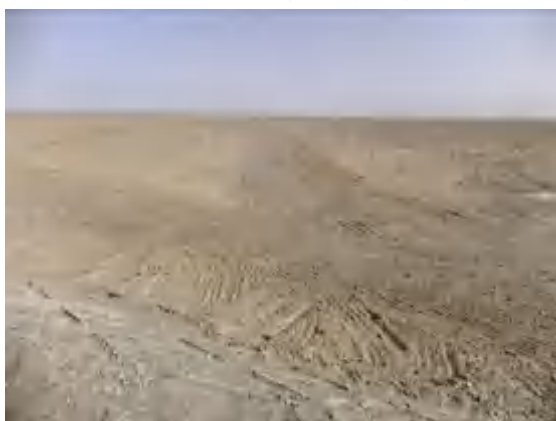
K2487+000 施工便道恢复状
