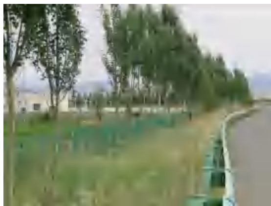
路基工程区边坡植被恢复
