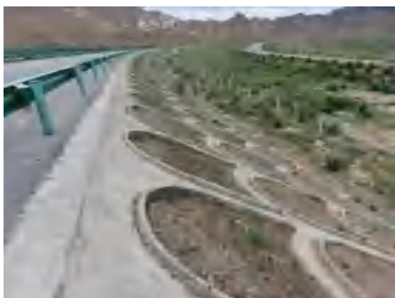
路基边坡拱形骨架护坡
