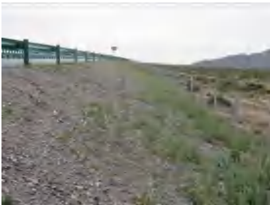
路基工程区边坡植被恢复
