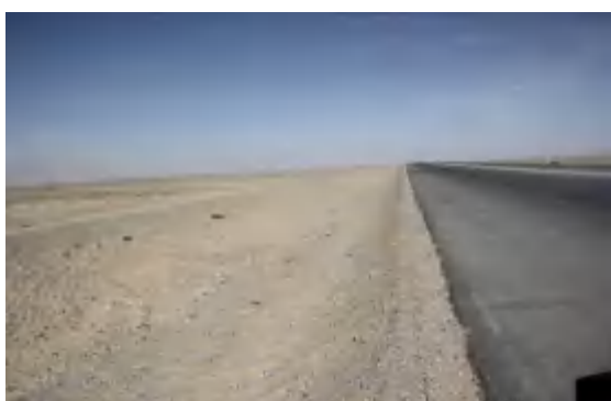
路基边坡土地整治
