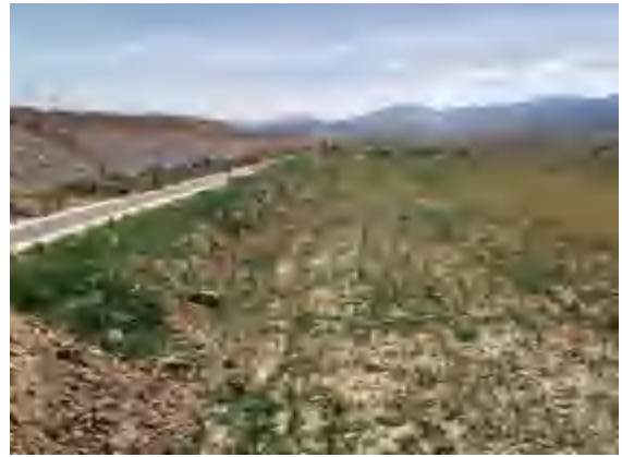
路基工程区边坡植被恢复
