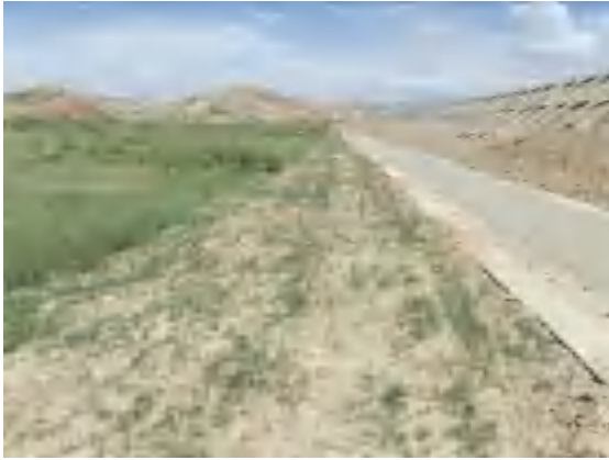
路基工程区边坡植被恢复
