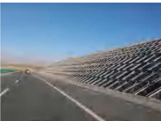
路基工程区骨架护坡
