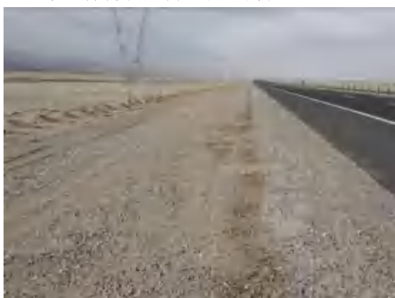
路基边坡土地整治
