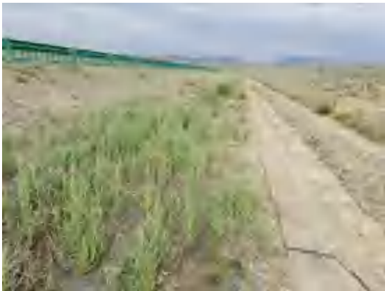
路基工程区边坡植被恢复
