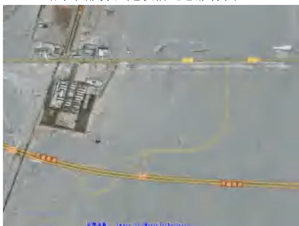
诺木洪收费站建设前遥感影像图
