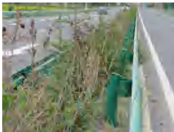
路基中央分隔带植被恢复
