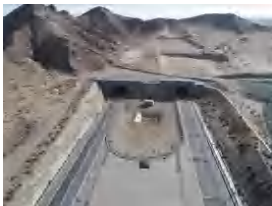
巴隆隧道进口
