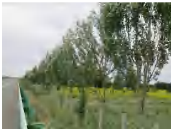
路基工程区边坡植被恢复
