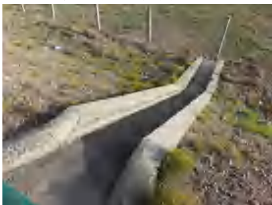
路基工程区边坡急流槽
