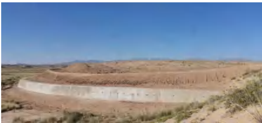
K2439+800 弃土场挡渣墙
