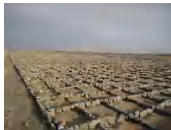
路基工程区片石方格网沙障
