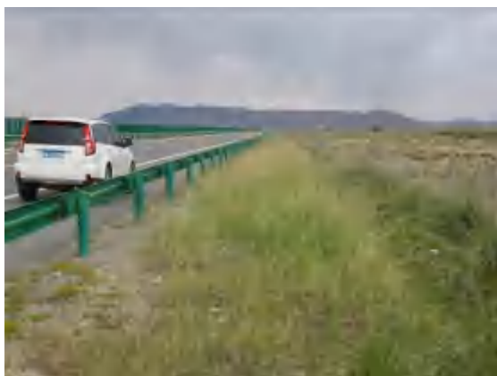
路基工程区边坡植被恢复
