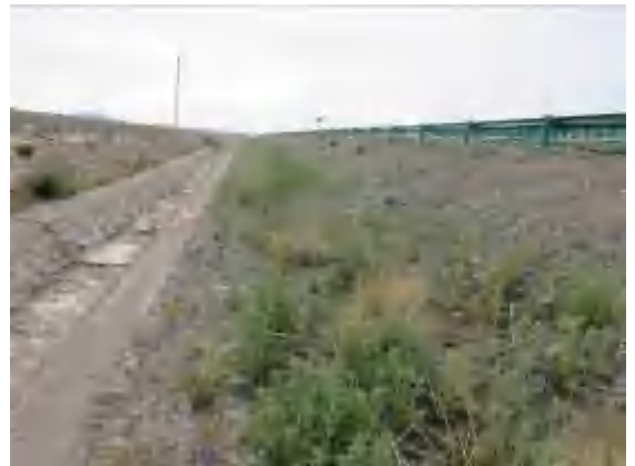
路基工程区边坡植被恢复
