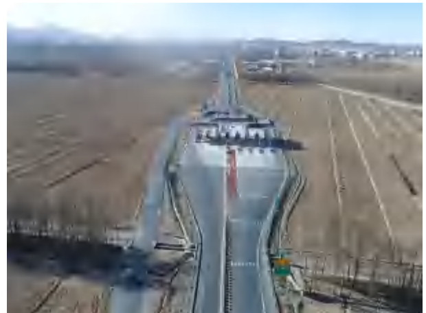
都兰互通立交及收费站建设中遥感影像图
