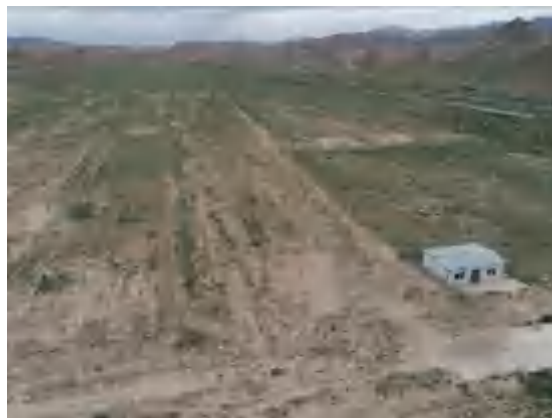
桥梁预制场恢复
