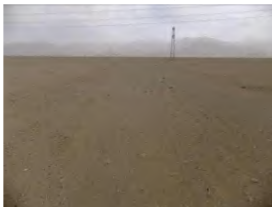
施工便道恢复状
