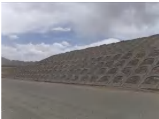
路基工程区骨架护坡
