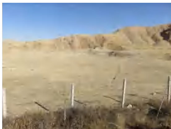
施工生产生活区恢复状
