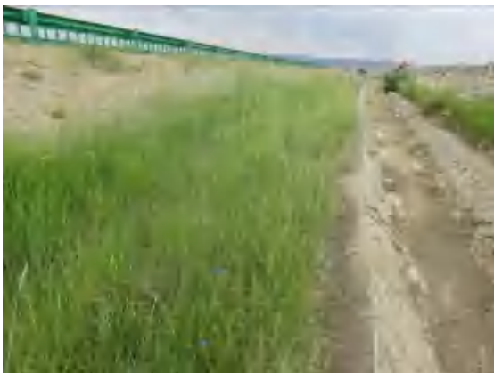
路基工程区边坡植被恢复
