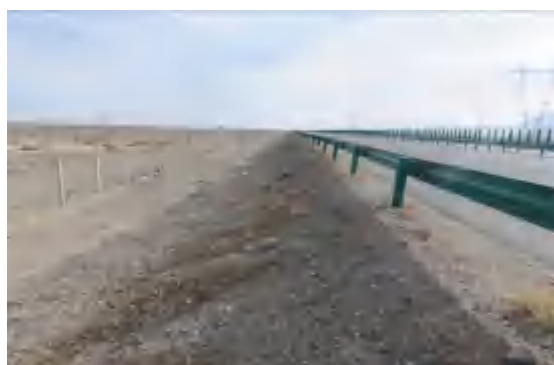
路基边坡土地整治
