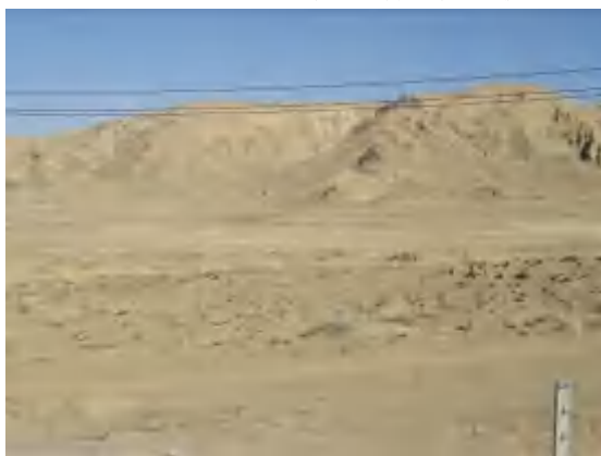
K2447+400 施工生产生活区恢复状
