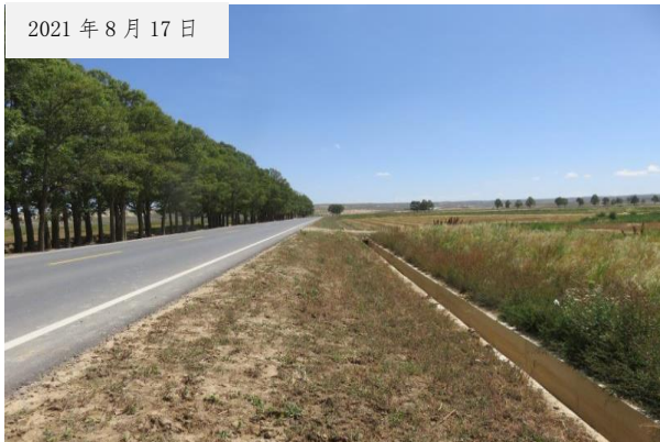
路基工程区植被恢复
