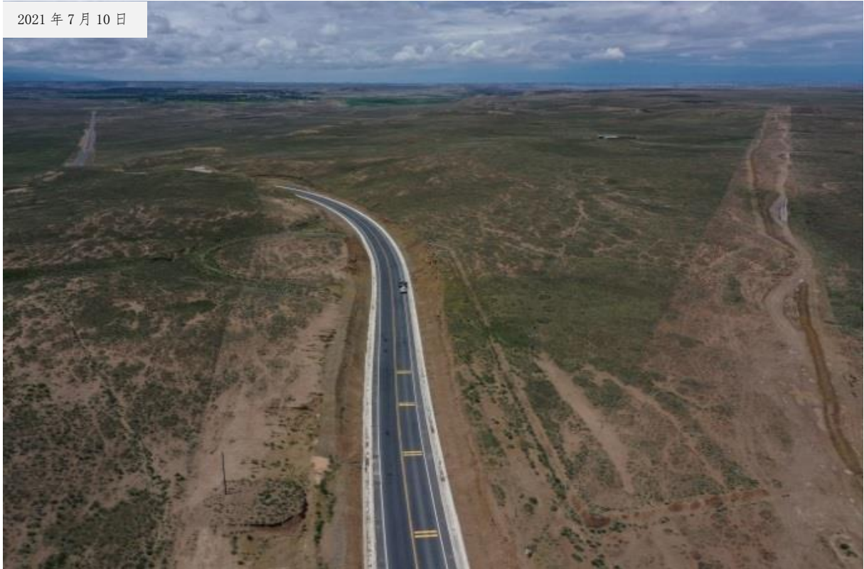
路基工程区植被恢复
