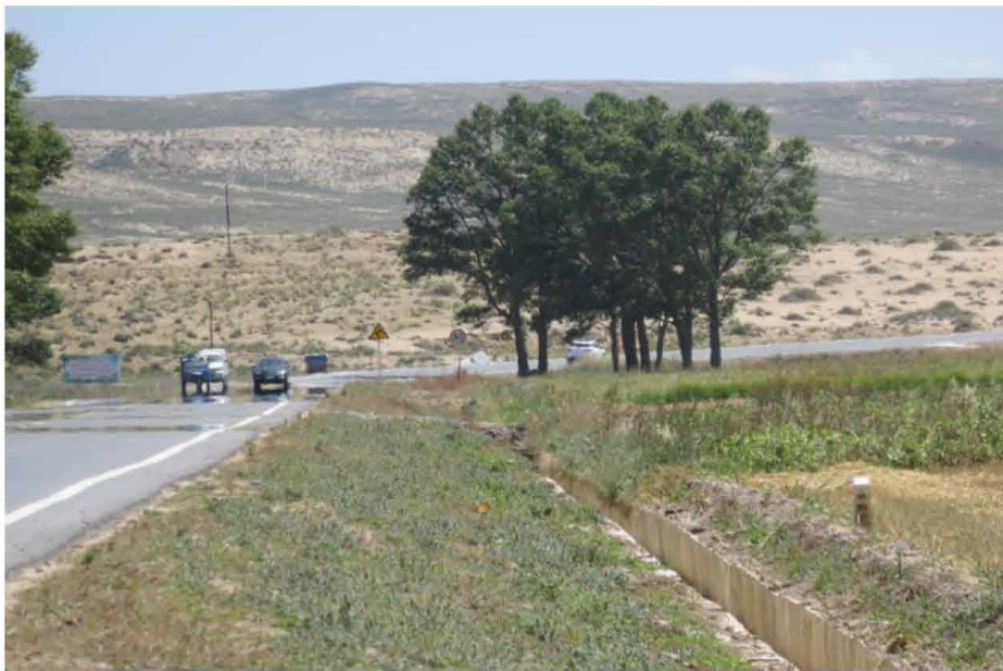
路基两侧恢复植被
