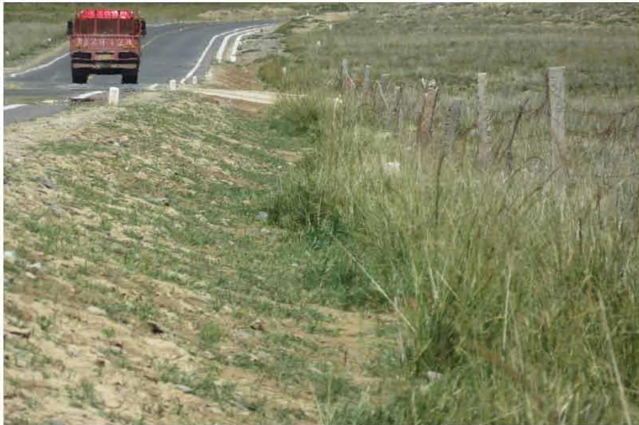
路基两侧恢复植被
