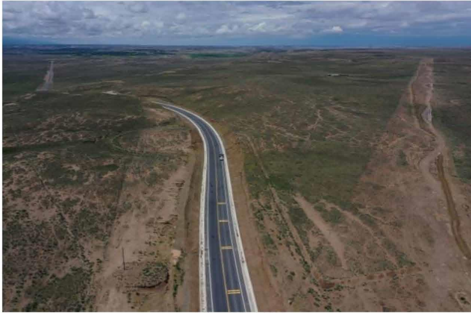
路基两侧恢复植被
