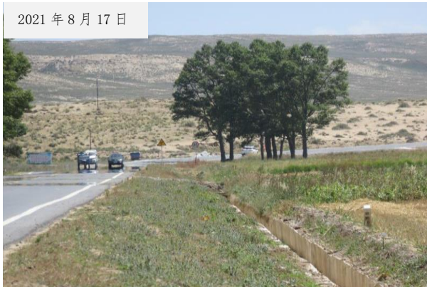
路基工程区植被恢复
