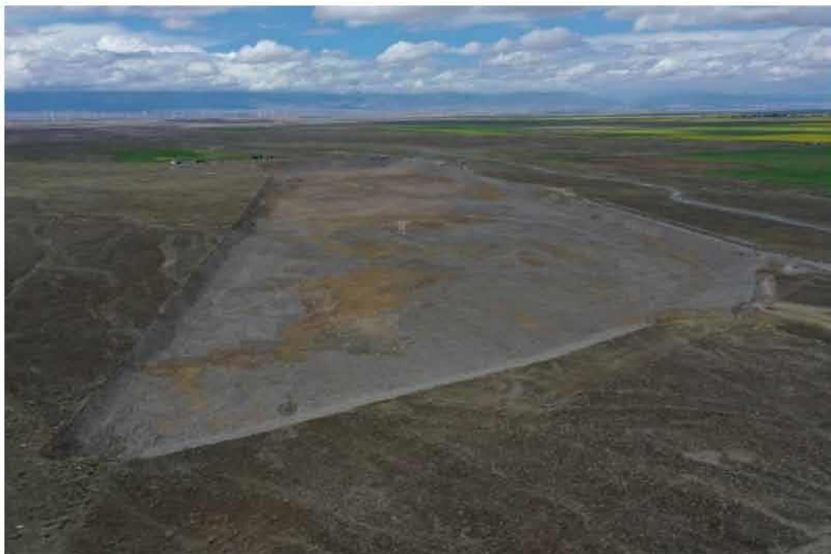
取土场削坡及土地整治平整
