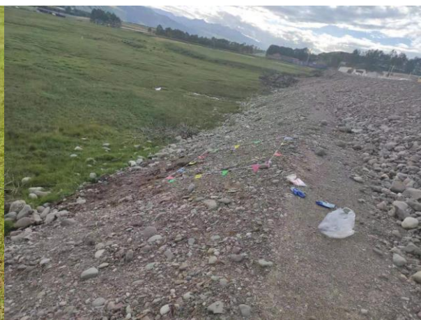
K196+400 路基边坡监测点
