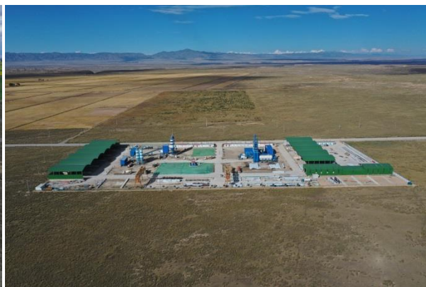
施工生产生活区监测
