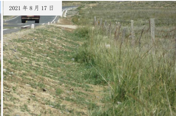
路基工程区植被恢复
