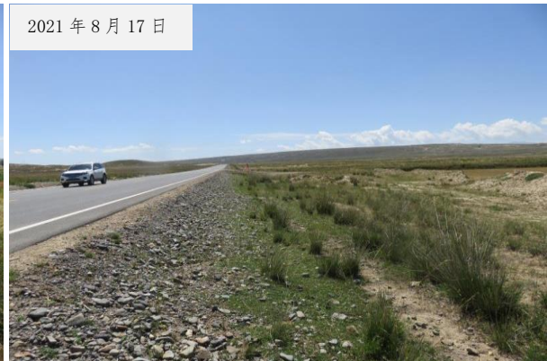
路基工程区植被恢复
