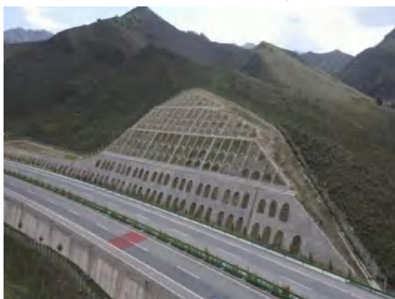
主体工程区路基边坡恢复
