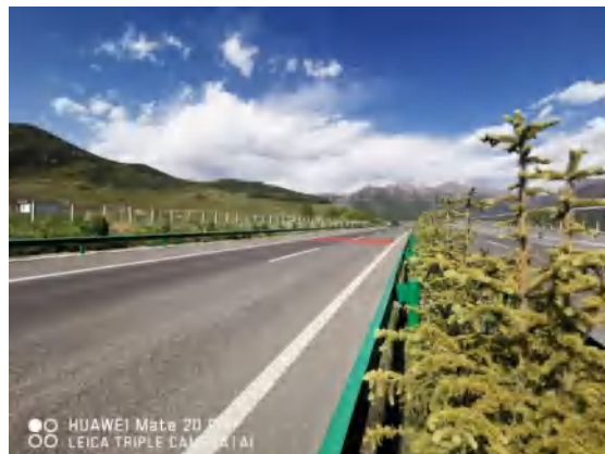
主体工程区路基边坡恢复
