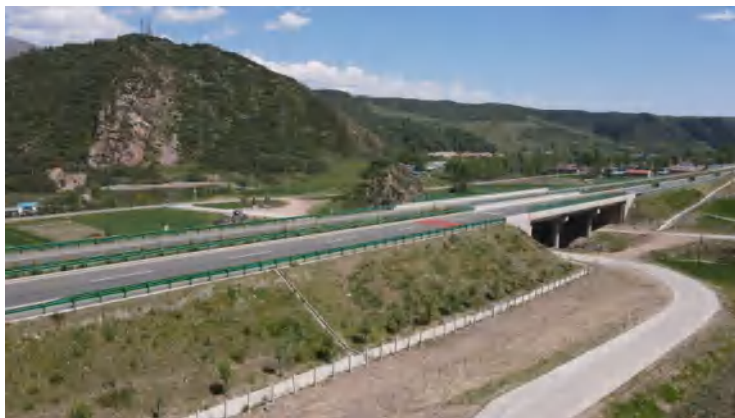
路基工程区排水边沟及植被恢复
