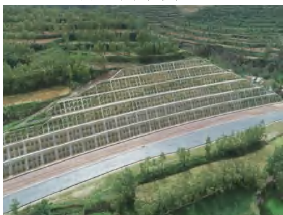
主体工程区路基边坡恢复
