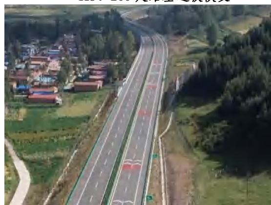
K95+750 处路基（半挖半填）恢复
