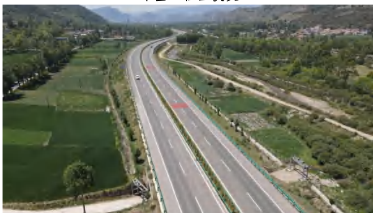
路基工程区恢复
