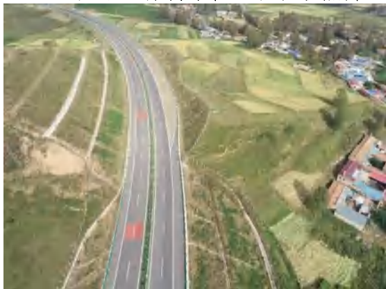
K93+750 处路基边坡恢复
