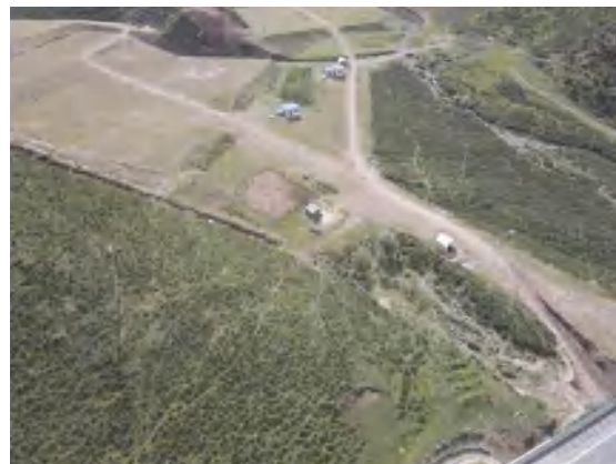
KD-SG2 标施工营地恢复现场
