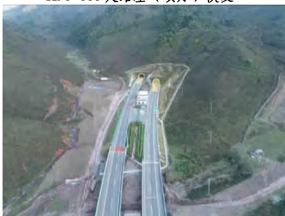
巴哈达板隧道进口
