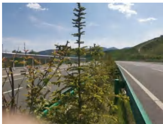
主体工程区路基边坡恢复
