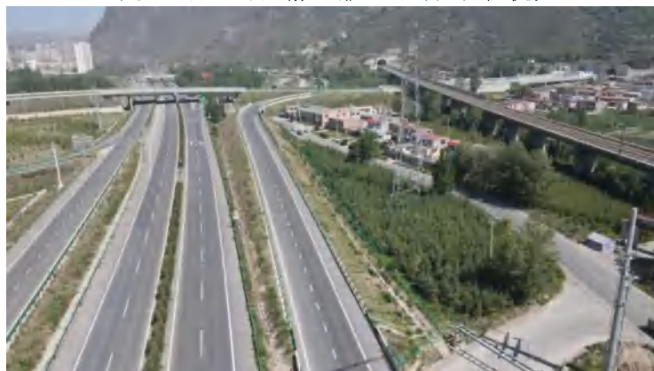
互通立交工程区恢复
