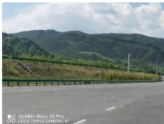
主体工程区路基边坡恢复
