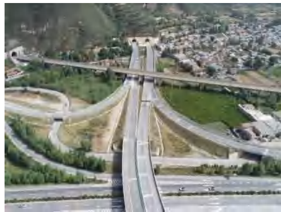
老管庄隧道出口
