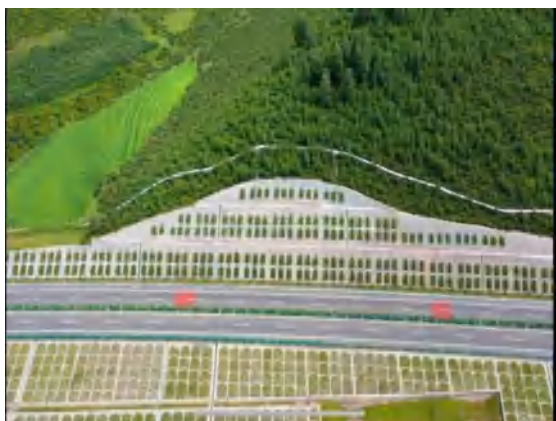
路基边坡植被恢复
