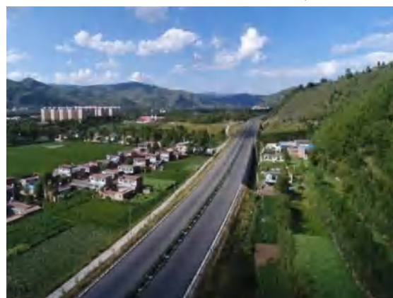
主体工程区路基边坡恢复
