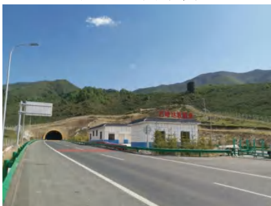
主体工程区路基边坡恢复
