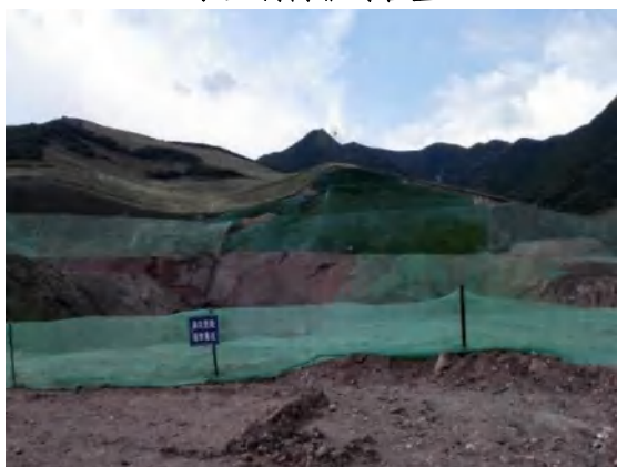
取土场边坡面临时苫盖
