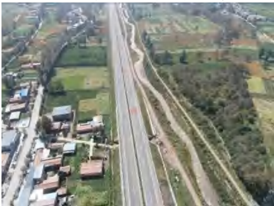
K111+100 处路基（填方）恢复
