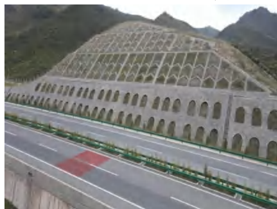
主体工程区路基边坡恢复
