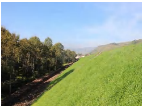
路基工程区边坡植被恢复
