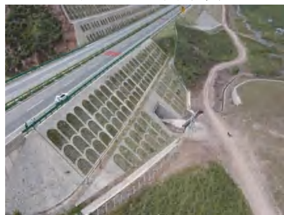
主体工程区路基边坡恢复
