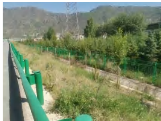
主体工程区路基边坡恢复
