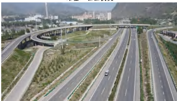
互通立交工程区恢复
