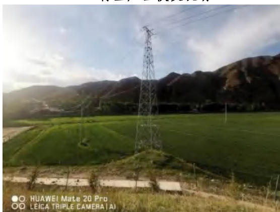
KD-SG4 标临时便道恢复现场
