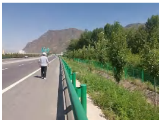
主体工程区路基边坡恢复
