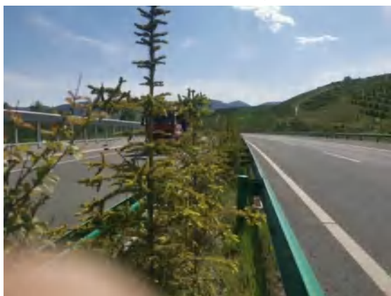
主体工程区路基边坡恢复
