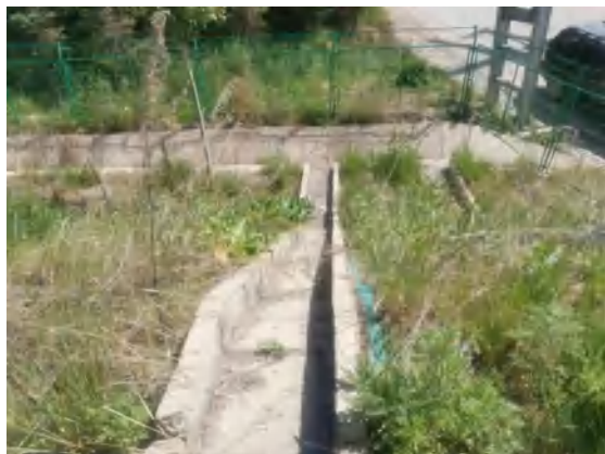
主体工程区路基边坡恢复
