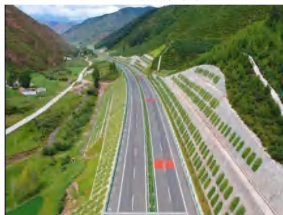
主体工程区路基边坡恢复
