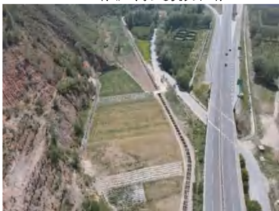
KD-SG7 标拌和站恢复现场
