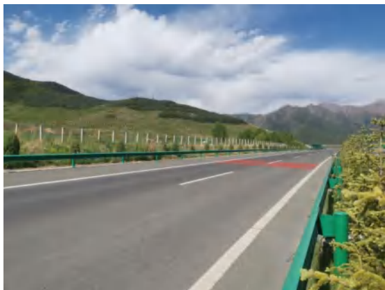
主体工程区路基边坡恢复
