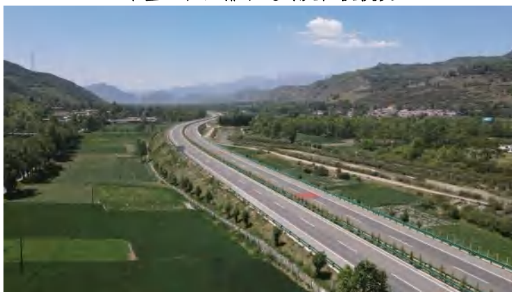
路基工程区恢复
