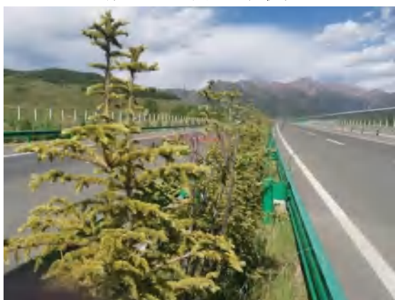
主体工程区路基边坡恢复
