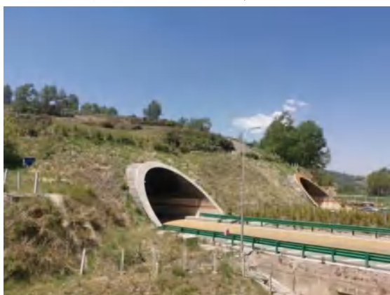
老管庄隧道进口边坡恢复
