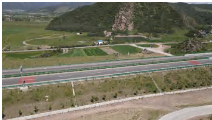
路基工程区急流槽、排水边沟及植被恢复
