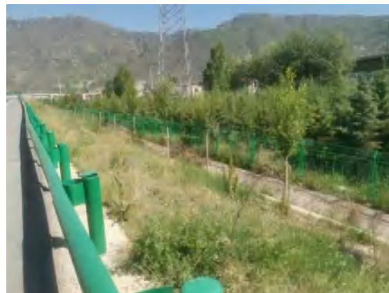
路基工程区边坡植被恢复
