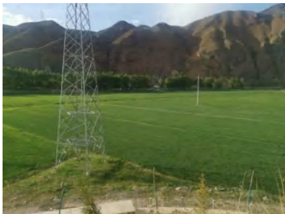
KD-SG1 标临时堆土点恢复现场
