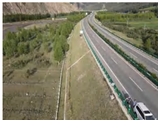
路基工程区边坡植被恢复
