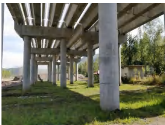
桥梁工程区植被恢复
