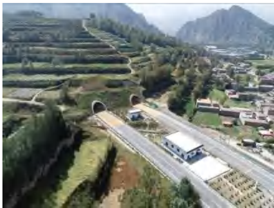
老管庄隧道进口
