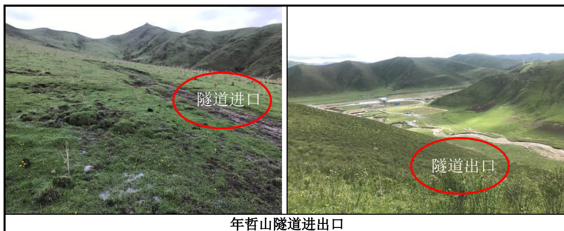
图 4.1-1 隧道进出口现状照片
