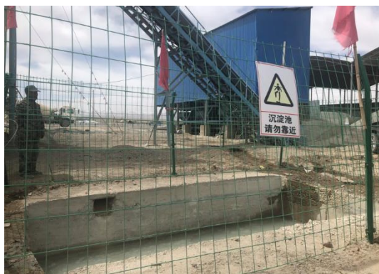
拌合站设置防渗沉淀池
