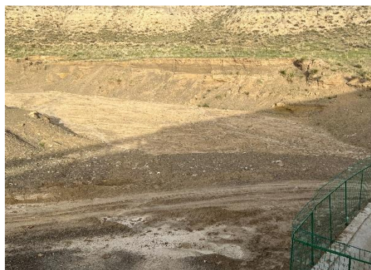
桥底河道清理疏通
