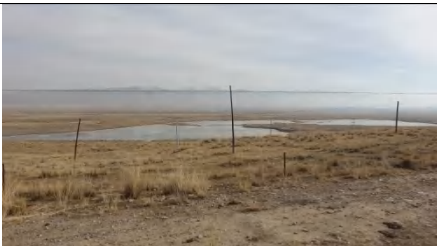
K116+200 东风村弃渣场
