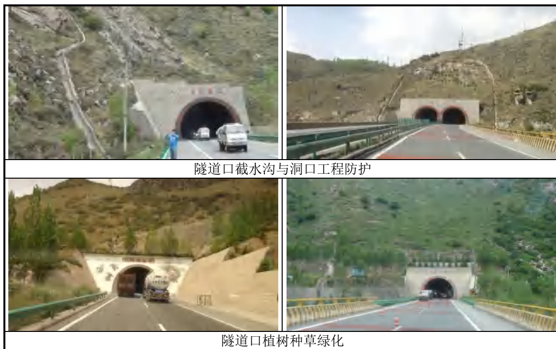
图 5.1-1 隧道口典型生态防治措施图
