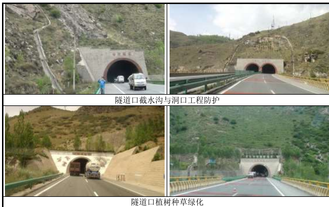
图 5.1-1 隧道口典型生态防治措施图
