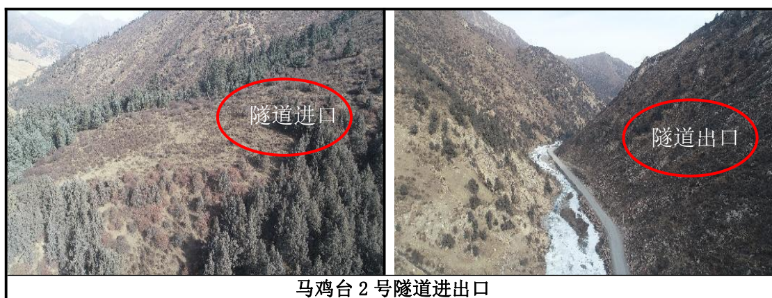
图 5.1-1 隧道进出口现状照片
